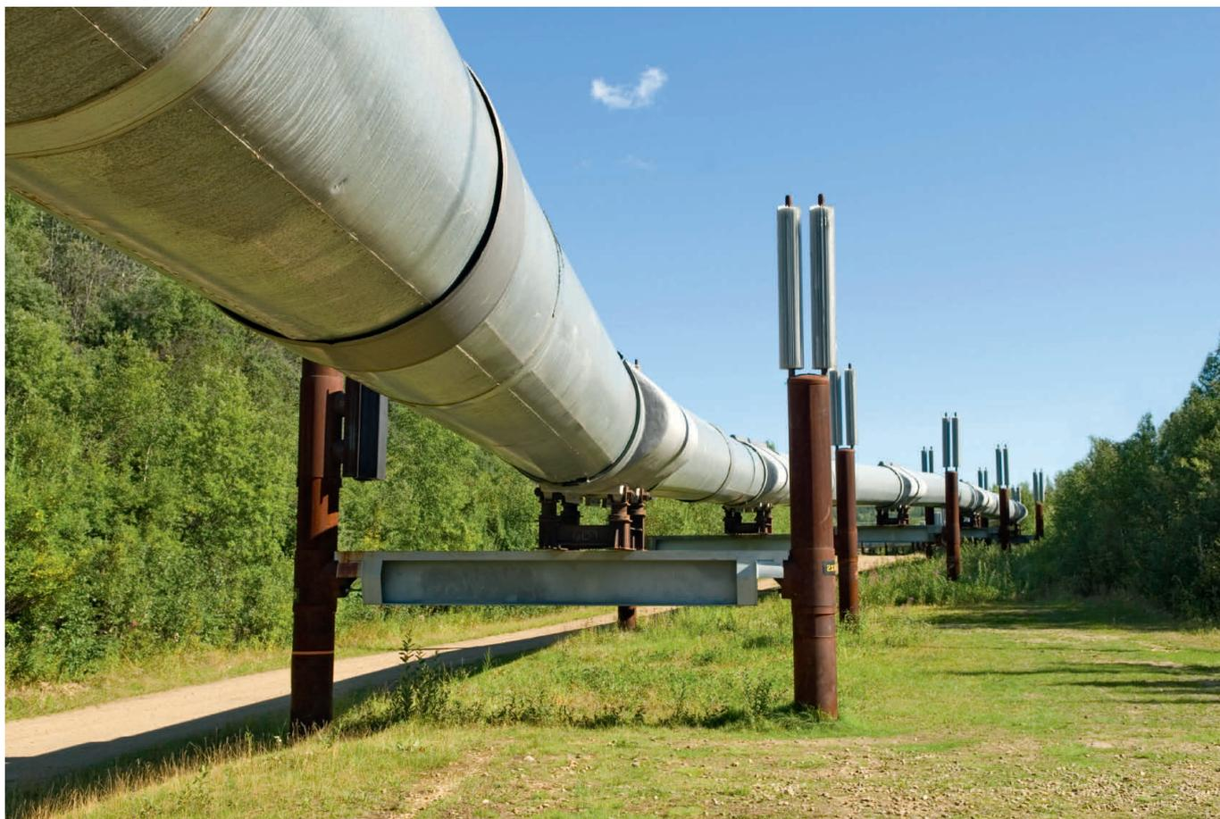
Rätsel im Rohr: Wird in Ölpipelines die Strömung turbulent, dann frisst die zusätzliche Reibung der zähen Flüssigkeit bis zu 80 Prozent mehr Pumpenergie. In den 1940er-Jahren entdeckten Ingenieure zufällig, dass im Öl gelöste Polymere den Strom beruhigen. Max-Planck-Forscher fanden nun heraus, warum.
