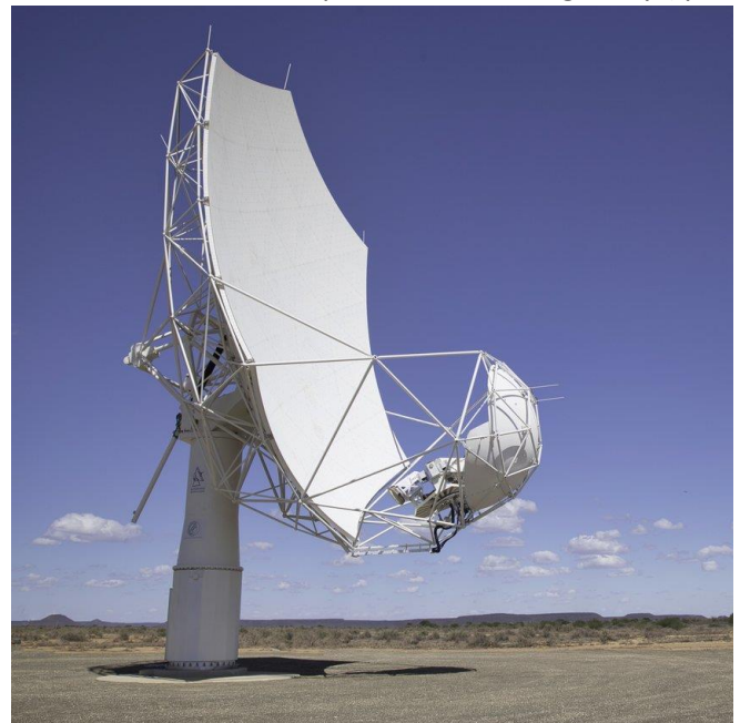
El Demostrador de plato SKA -Max Planck operando en el desierto de Karoo. La antena proporciona un banco de pruebas para la ampliación del conjunto de telescopios MeerKAT dentro del proyecto MeerKAT+. © Gundolf Wieching/MPIfR
